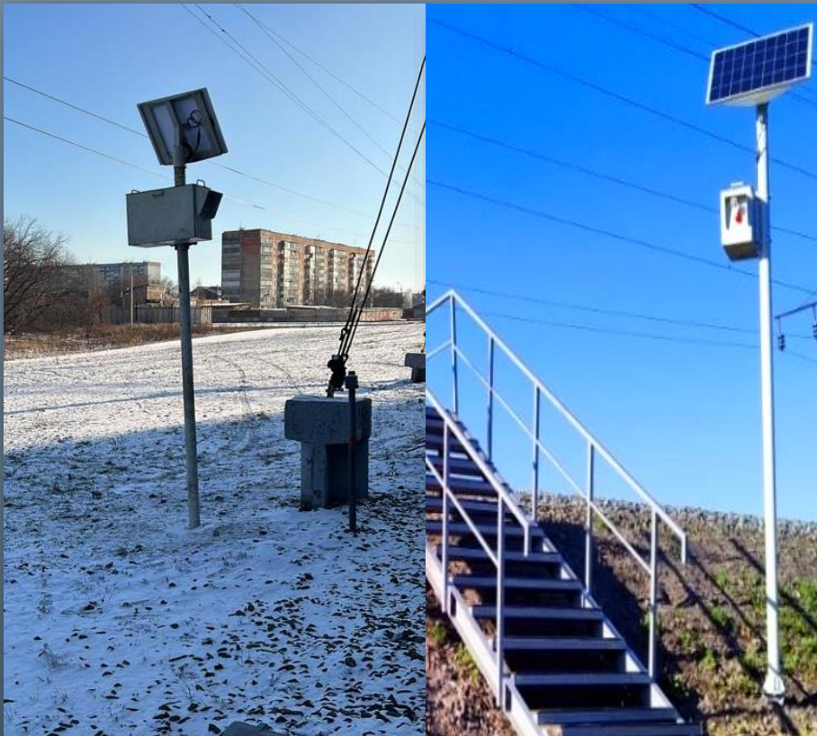
Установка речевых оповещателей
